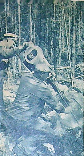
På vissa avsnitt har man fått spränga sig fram meter för meter. Här ses en motordriven Warsop berghornmaskin i arbete.
