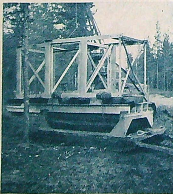
Traktordrögar av denna typ används för transport av syllfundament, stolpunderdelar samt verktyg.
