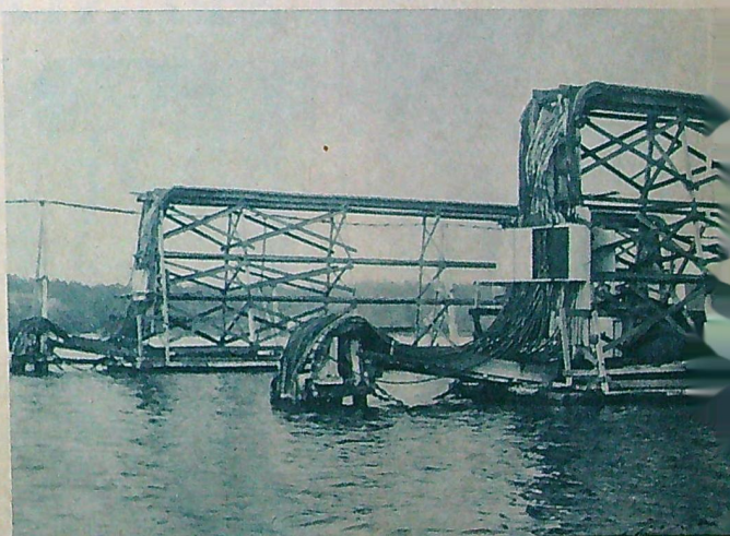
Avmagnetiserings-slingan, som matas med lågperiodig växelström, består av fyra stycken U-skiuklar, varav två är placerade ovanför vattenytan. I bakgrunden skymtar nollslingan.
