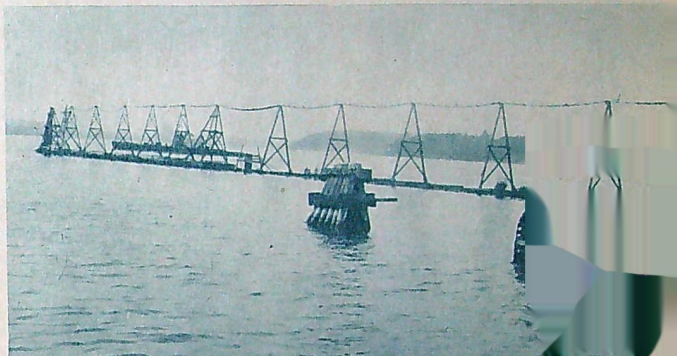
En del av den 200 meter långa nollslingan, vars andra långsida ligger på sjöbotten och vars normal pekar mot den magnetiska nordpolen — alltså ned i vattnet mot Lidingön t. h.
