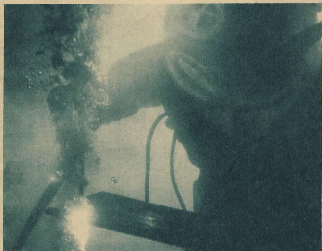
5 Under vattnet får dykaren bl. a. lära sig att skära i stål.
