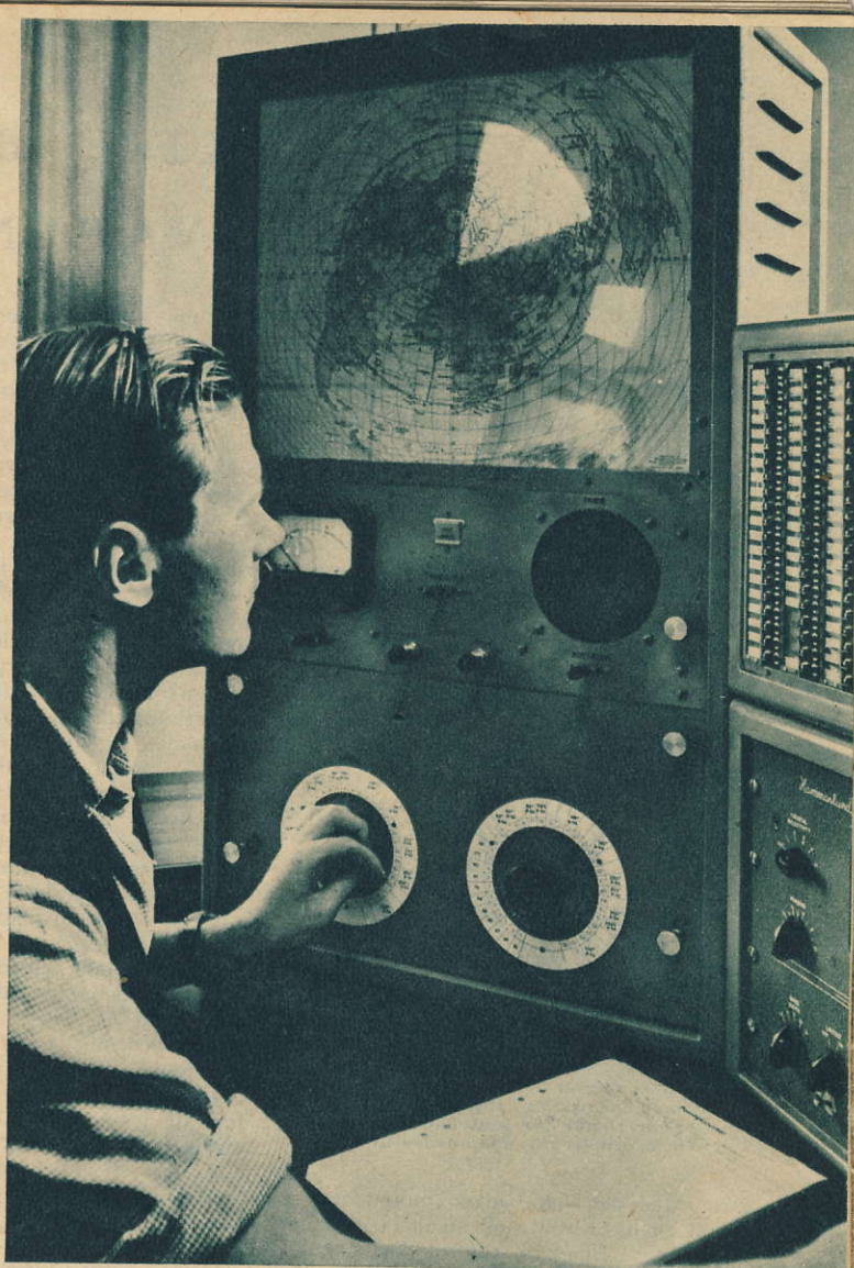
Expediering av ett telegram från ett av de små expeditiionsrummen. Telegrafisten väljer med den vänstra ratten ut lämpligt riktantennsystem — varvid en ljussektor markerar den valda riktningen för sändarantennen och ett ljussegment riktningen för mottagarentennen.
