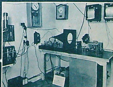
Den automatiskt registrerande meteorspaningsanläggningen består av ett 30 cm:s katodstrålerör samt framför det en filmkamera som tar en bild var femte sek. Vänstra klockan anger lokaltiden för Göteborg.
