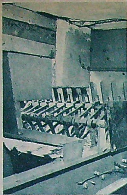
Matningskrattan som ses på bilden ovan har elva matningsplaner. En kolv av specialstål fångar halmen och för den mot en kniv som skär den.
