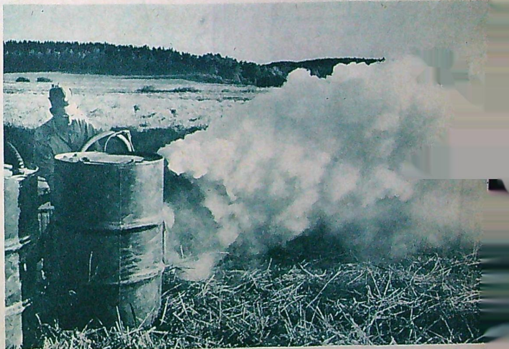
Det första fotot av en svensk dimbildare, som här ses i aktion vid Södertälje kanal. Gasen bildas av olja som kondenseras i så fina droppar att de inte faller ned till marken.
