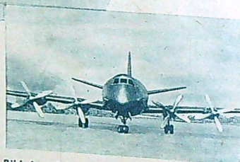
Bild framifrån, visande de dubbla hjulen och det höga sjöårspartiet, vilket gör ytterligare trimning överflödig vid ändring av motorstyrka eller utfällning av klaffar och landningsställ.
