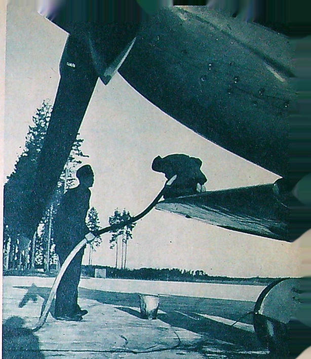
Det fordras en hel del »soppos» för att mata över 2.000 »hästar» under sex timmar. På Spitfiren har man därför utnyttjat alla tillgängliga utrymmen för bränsletankar och här får vingtanken, som sträcker sig över hela framkanten, påfyllning efter en övningsflygning.
