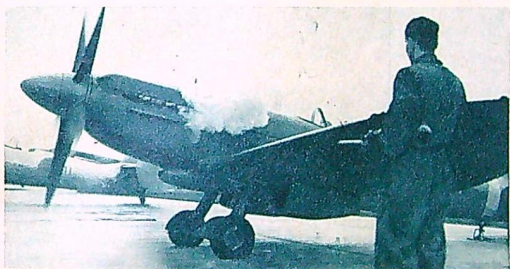
Motorn startas med en startpatron — en krutladdning — som bringas att explodera i en av cylindrarna. Här har »skottet» gått.
