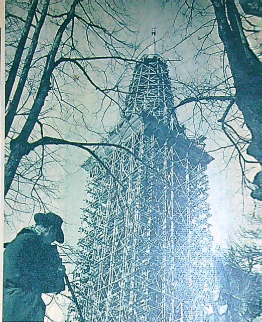
Johanneskyrkan med sin byggnadsställningar såg oerhört ut. Det blev ett bra svikerts. Grenarna bildar en vacker ram.
