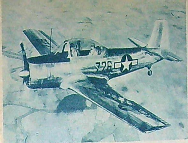
Fairchild T-31 heter det senaste amerikanska skolflygplanet. Det är utrustat med bubblekabin och dess instrument och kontrollutrustning är sådan att det kan användas både för grundläggande och mer avancerad utbildning. 100 plan har redan beställits.
