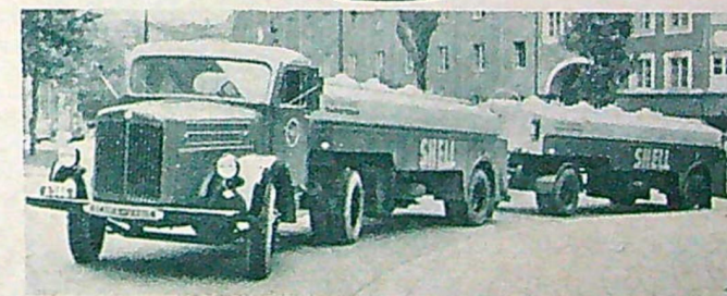
AB Svenska Shell har satt in ett tankbilståg för transport av petroleumprodukter. Tåget består av dragvagn plus två påhängsvagnar, lastar 16.200 l och är 20 m långt och 2,20 m brett. Trots storleken kan det manövreras lätt i trafiken. Se upp när ni möter tåget i ett gathörn.
