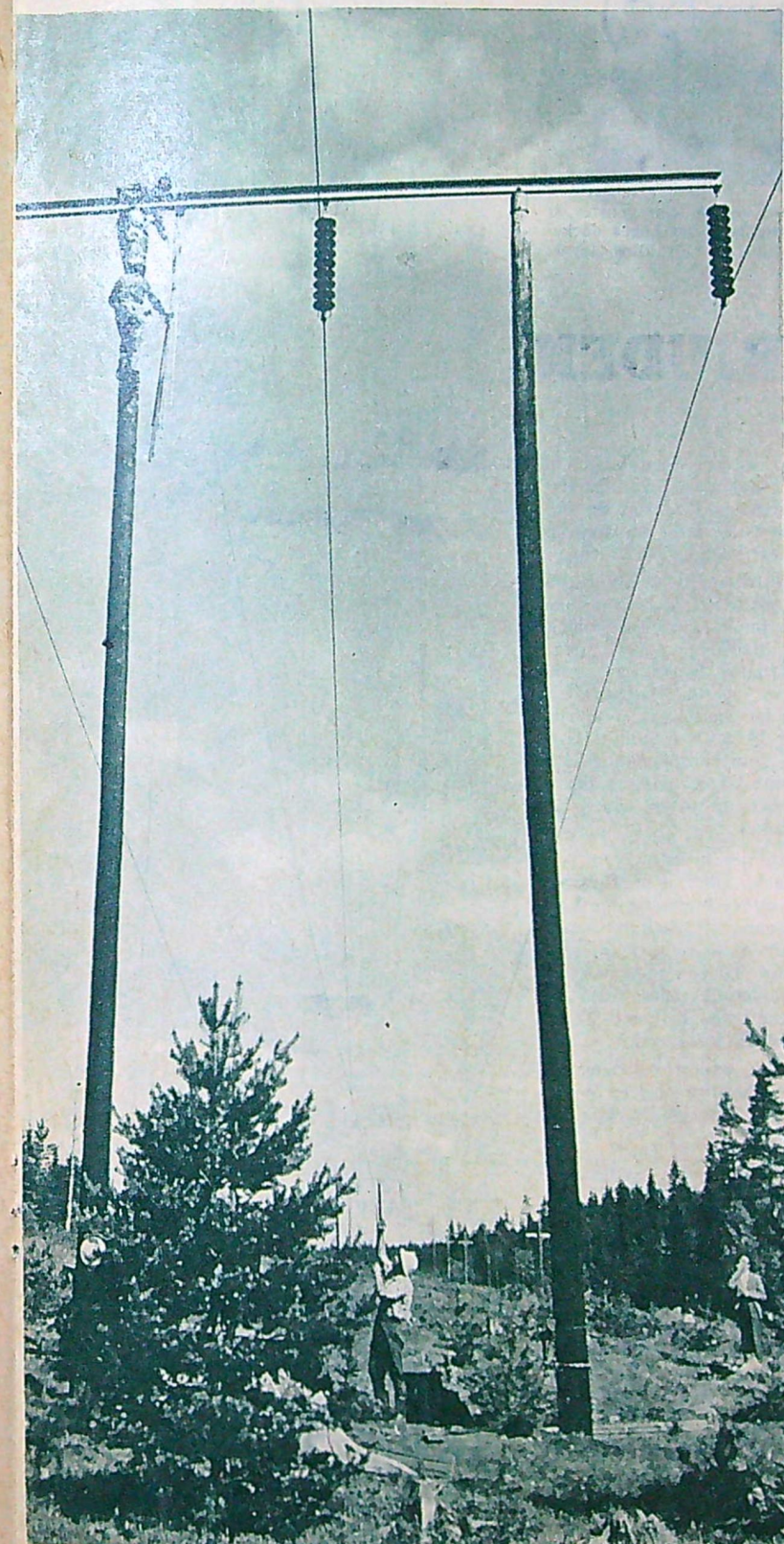
Första linjegubben till väders har block och lina med sig upp. När blocket fastgjorts i tvärlåsen kommer verktygen. Varje arbetsmoment måste gå lugnt — de isolerade stängernas ytbehandling får inte skadas då det endast är denna som skyddar linjearbetaren från den farliga strömmen.
