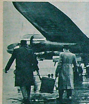
3 Den lilla blybehållaren placeras i ett fack i flygplanets vinge. Preparatet förvaras där under transporten så att avståndet skall bli tillräckligt långt för att den farliga strålningen inte skall kunna nå passagerarna. Planet befördrar regelbundet radioaktivt material till Sydafrika.
