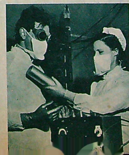
10 Med Geigermätaren kontrolleras efter undersökning med radioaktiva preparat att läkarnas och sjuksystemernas kläder inte blivit radioaktivt »besmittade».
