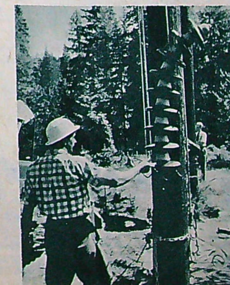
Den reparerade isolatorkedjan är klar att hissas upp. Det tar ungefär en timme att byta en kedja, och man spar både tid och pengar om det sker medan ledningen är strömförande.
