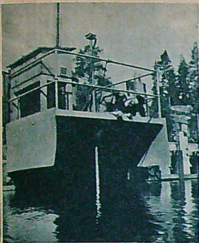
Laxräkningsverk i Gide älv. När fisken simmar förbi den vita stängen blir den registrerad i räkneverket.
