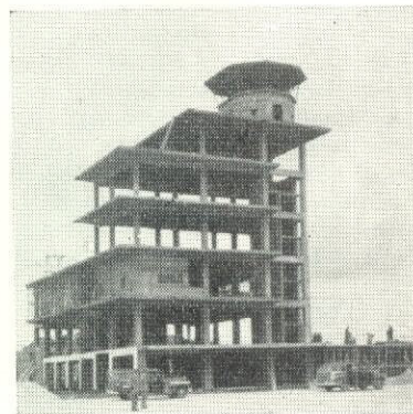
Överst. Departement of Civil Aviation, flygministeriets hus, i Beirut T. h. Flygplatsen i Beirut, stationsbyggnaden under uppförande
