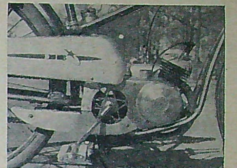
Närbild av JB-motorn. Kedjan är som synes väl inklädd, och allt som har med motorn att göra är koncentrerat och har fått lägsta möjliga placering.
