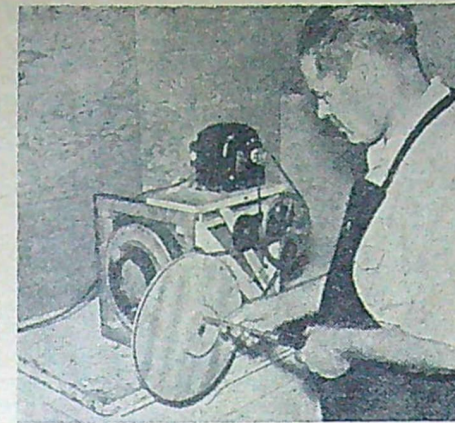
Sista justeringsarbetet: motorn med remskivorna är satta på sin plats.
