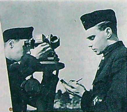
En väderballong har släppts och i mätinstrument följer Göran Dahlgren och Lennart Lagerholm hur den reagerar inför vindarnas behandling vid markskiktet.
