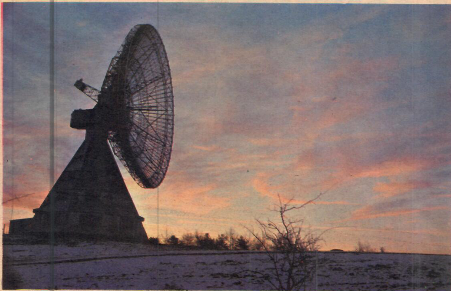
På det 435 m höga Stockertberget står Tysklands stora radioteleskop, vars väldiga spegel har en diameter på 25 m och en mottagningsyta på 500 m 2 .
