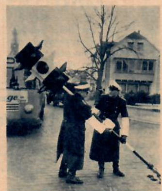
Portabla trafikljus används på försök i Tyskland. På några minuter kan de sättas ned i ett hål i gatan där de för tillfället bäst behövs.
