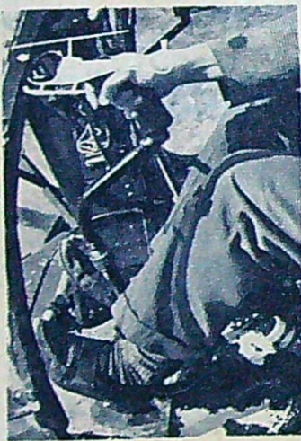
Drar man styrspeken bakåt, lutar rotorn åt samma håll med följd att köptern flyger baklänges. Skjuts den framåt (t. v.), flyger vi framåt. Rörelserna på de här bilderna är överdrivna. Det skall vara små utslag.
