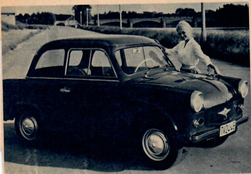
Den östtyska Trabant, efterföljare till IFA P70, produceras nu för fullt. Motorn är en tvåcylindrig tvåtaktare på 18 hk vid 3750 v/min och topparten beräknas till 90 km/t. Hjulen är 13 tums.
