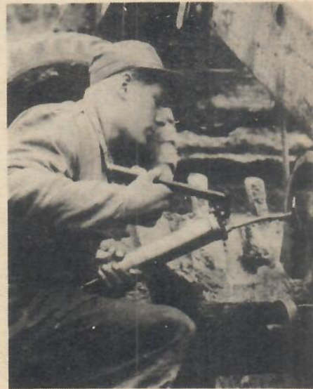
Det hårda arbetet och tempot kräver perfekt maskinkötsel. Rundsmörjning efter varje skift.
