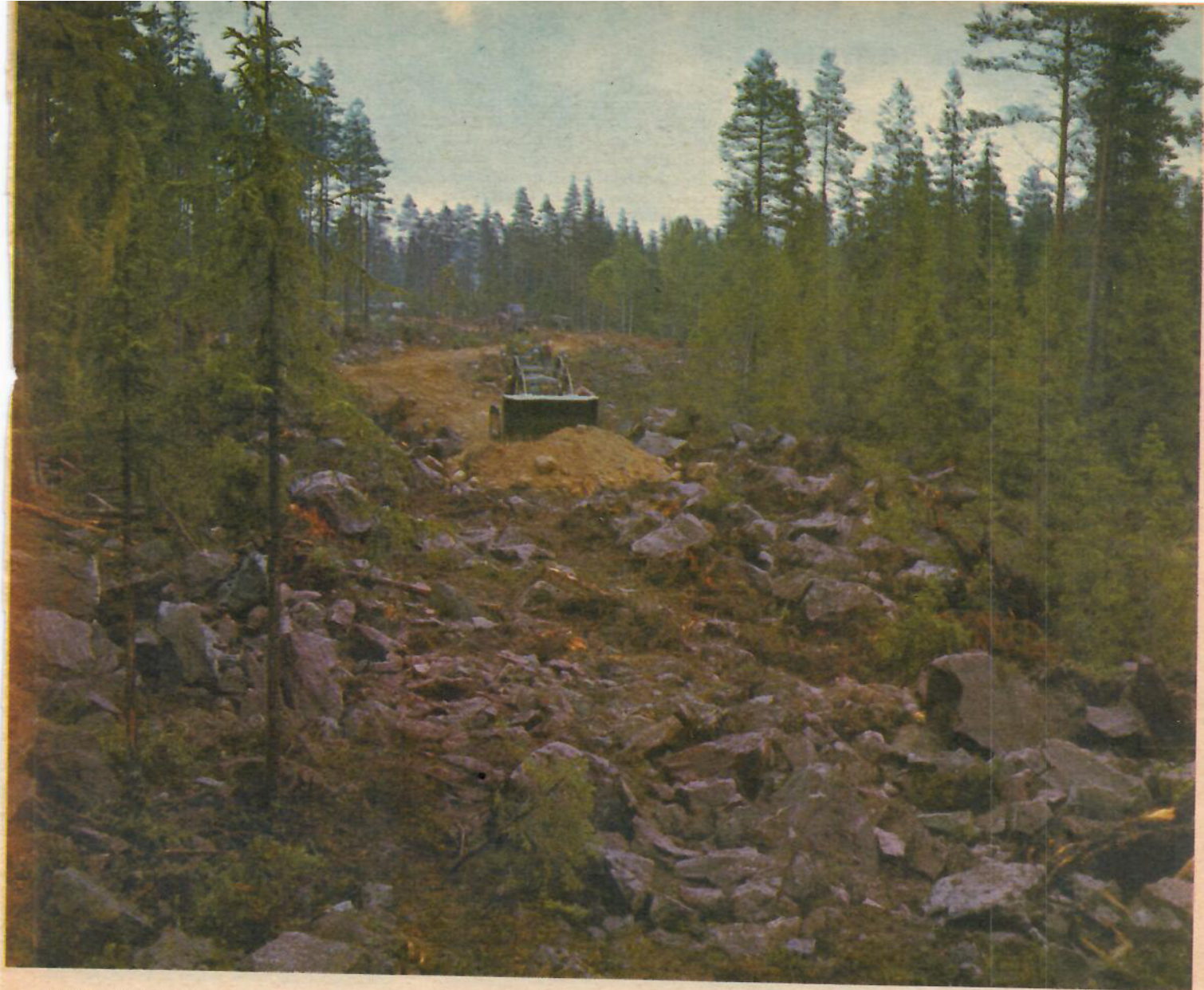
Att här pågår vägbygge är inte att ta miste på. Men att det om några timmar skall vara färdig väg ungefär där kameran står förefaller nästan otroligt.
