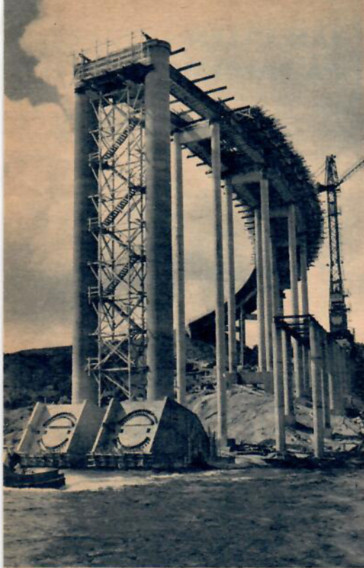
Tredje bronns mäktiga landfäste på Almö-sidan. Mot betongfundamentet i förgrunden skall spannet vila. T. h. en särskild bro för arbetskranen.
