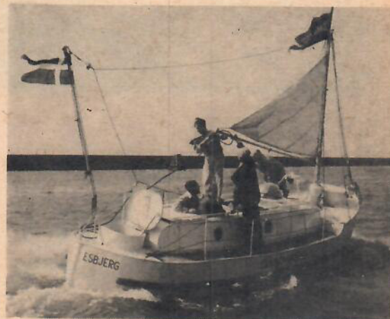
Det lilla stageglet är en idé som räddningsbåten lånat från fiskekuttrarna. Det skall hämma båtens krängningar i grov sjö. Luckorna i för och akter kan slutas vattentätt.
