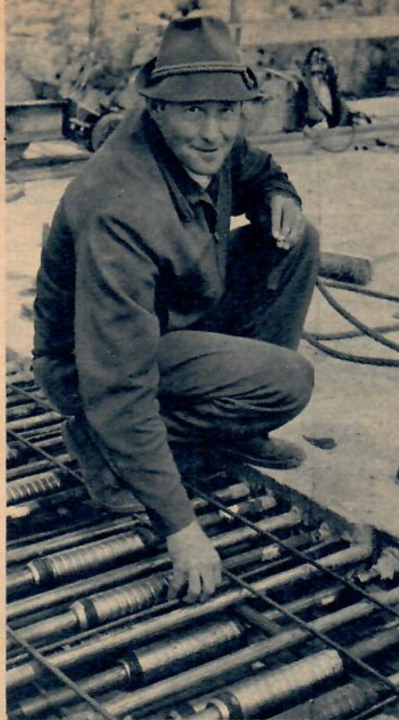
Hundratals armeringsjärn bär upp bronns tyngd. T. h. slutar ett med en platta och spännmutter. Vid ing. Skoglunds hand syns några skarvhylsor.
