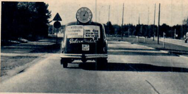
IC:s servicebilar har fått hastighetsmätare i kromosformat fastsatta på taket och riktade så att de efterföljande bilarna lätt kan läsa av farten. Bilisterna kan alltså kolla sina egna hastighetsmätare...
