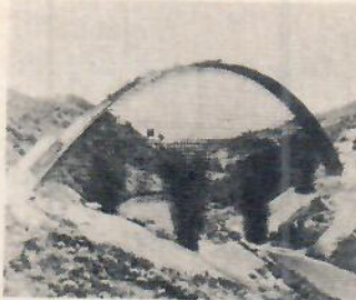
En ny nord-sydlig riksväg byggs genom hela Italien. Bilden ovan visar en originell viadukt nära Florens.
