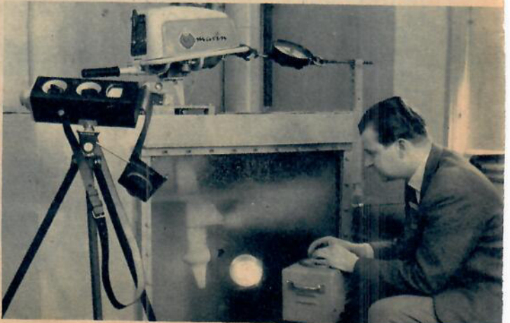
Ingenjör Gösta Stillerud har hand om NV:s marina laboratorium. I ljuset från ett stroboskop studerar han här hur propellern uppför sig under gång vid olika varvtal (ned.).
