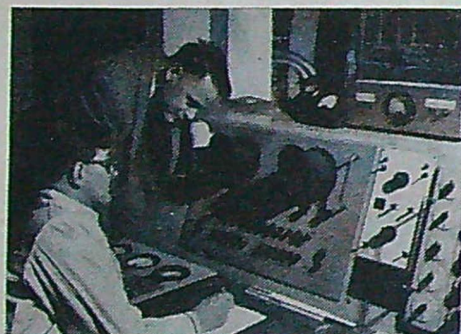
Bilden visar ett instrumentbord i det stora kontrollrummet. Det krävs en omfattande apparatur för att mäta och dirigera de väldiga krafterna.
