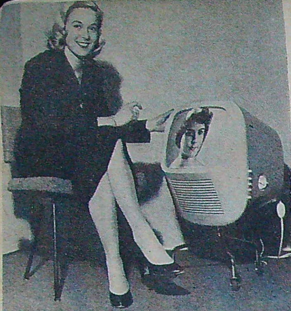
På årets Hannover-mässa visades bl. a. den här TV-mottagaren från Telefunken. Än så länge finns den bara i ett enda exemplar. Under det elegant formgivna höljets döljer sig ett standardchassi med tryckta kopplingar och ett bildrör på 43 cm.
