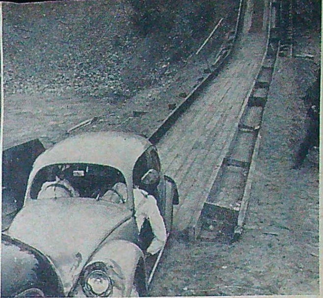
Starten går — och så gick det. T. v. ses en Volkswagen rutscha utför backen och ovan ses situationen efter "kollision med parkerad bil". Dockan t. h. på bilden, som bar ett bälte av hängseltyp, kastades mot vindrutan, som föll ur. Den andra bar VW standardbälte och klarade den relativt lindriga krocken.
