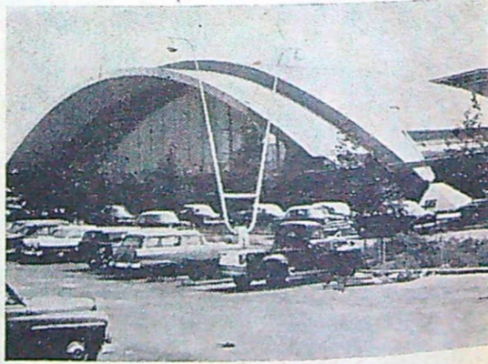
Entrén till New Yorks internationella flygplats skyddas av en valvbåge av rostfritt stål. Bågens spännvidd är 63 m, bredden 32 m och höjden 14 m. Även ankomsthallens tak täcks med rostfritt stål.
