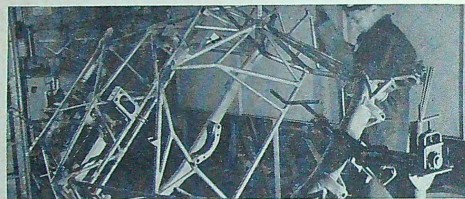
1 Den säregna ramkonstruktionen till Mercedes 300 SL Roadster svetsas till en början i en fast gigg, se övre bilden. När "skelettet" börjar ta form, hängs ramen upp i en arbetsställning, där den kompletteras med rör av olika dimensioner. 147 stråvr och fem lådbalkar bildar hela konstruktionen.
