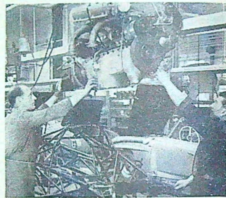
2 Den imponerande 225-hästarmotorn är det första som plockas in i ramen. Motorn monterar i 40° vinkel mot lodlinjen för att spara höjd.
