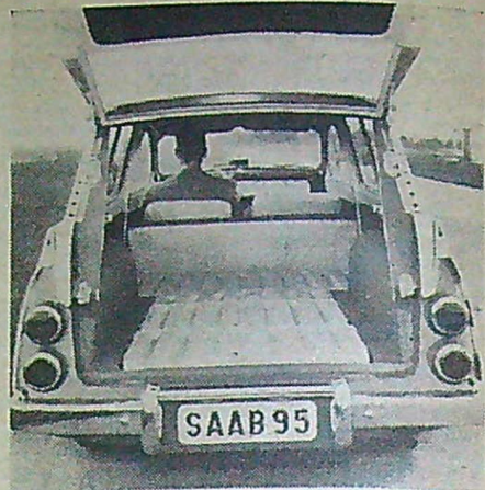
Med två personer ombord är vagnen besiktigad för 300 kg last. Det sammanhängande lastutrymmet blir 2,05 m långt, när sätena skjuts framåt.
