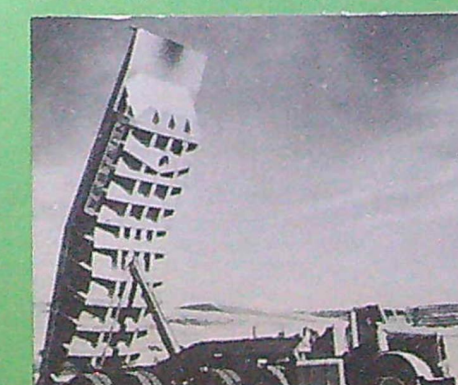
Hela 165 ton lastar denna amerikanska "tungviktslastbil", som rullar på 18 däck av dimensionen, 18x33. Flakets framkant är 13 m över marken, dā lasten tipsas. Toppfarten ligger pā 55 km/tim.
