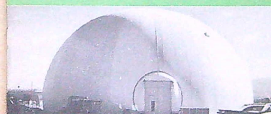
Delta jättetält påminner slående om en väldig eskimå-igloo. Kupolen hålls uppe av komprimerad luft, som oavbrutet pumpas in. Kupan finns i Palo Alto i Californien och döljer en antenn.
