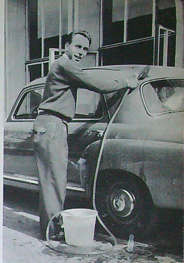
En tysk fabrikör, Gerhard Oelsner, presenterade vid Frankfurt-utställningen den här behändiga tvättanordningen för bilar. Vatnet sugts upp från spannen, när man bearbetar bilen med borsten.
