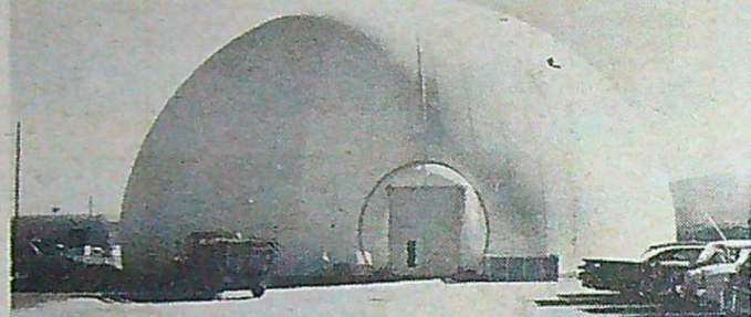
För en ny simhall i Nässjö bygger man den här luftiga kupolen. Främsta fördelen är att byggnaden hålls uppe av den luft, som finns i kupolen.
