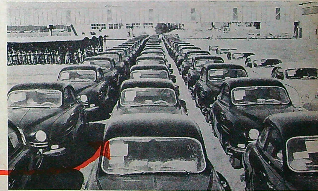
Alla karosstransporter inom måleriet sker via s. k. conveyor, dvs. antingen en hängbana eller som ovan, en räls som går i slingor från den ena ugnen till den andra med inspektion däremellan.
