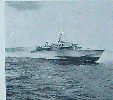
Gasturbinen har så smått börjat ta loven av kolv- motorerna, när det gäller snabba farkoster till sjöss och i luften. På bilden ovan världens första gasturbin drivna motorpropellerbåt, den engelska "HMS Brave Borderer" på femtio knops provtur i Engelska kanalen. Med den topparten är båten än så länge världens snabbaste örlogsmann. Som kraftkälla i experimenten byggts används en Proteo gasturbin av samma typ som i en del brittiska trafikflygplan. Turbinen utvecklar en högsta effekt av 4250 hästkrafter. Därutöver förekommer inga hjälpmaskiner. Svenska flottan har intresserat sig mycket för experimenten för eventuella inköp.
