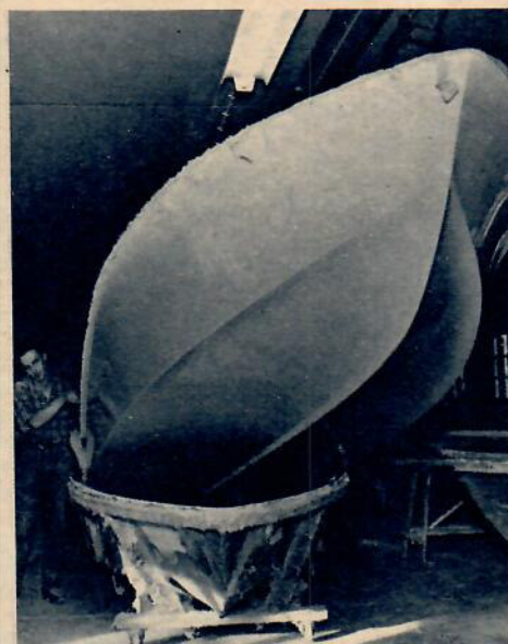
Det färdiga skrovet lyfts ur sin form och bör redan då vara blankt och slätt. Råkanten upp till skärs av med en sågklinga. Den grova väven är den s. k. rowingväven som ligger innerst.
