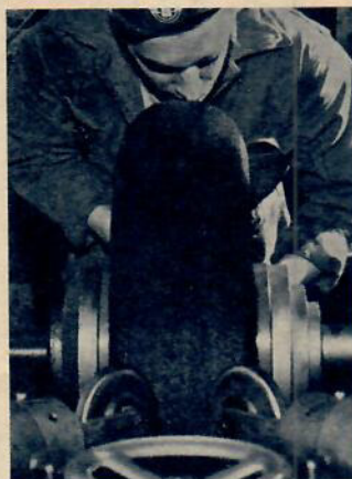
Stommen sprutas med vulkement. Detta sker för att slitbanan skall kunna fixeras och behålla sitt läge till dess däcket sätts in i formen.
