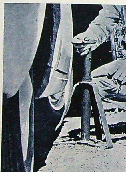
Likaså är pallbockar absolut nödvändiga. Även om domkraften är perfekt skall man inte lita på den — olyckan kan vara framme...
