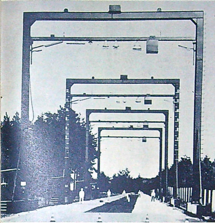
Siemens har byggt ny provväg för utprovning av belysning av vägar.
