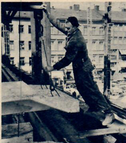
T. v. bärande stål- element i närbild samt montering av kasset.
