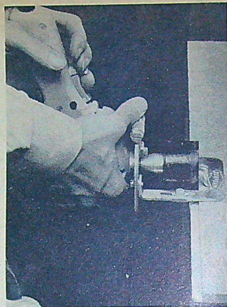
Här fräses ett spår med fräscylindern i kombination med falstillsatsen. Maskinen måste hållas stadigt.
