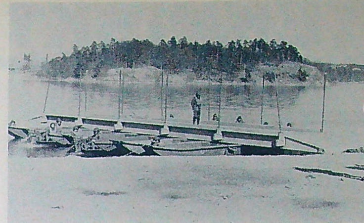
Den låga vikten möjliggör att bron kan användas som färja. Den tar även då 25 ton.
