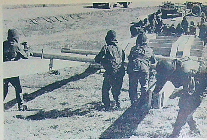
Efter 12 minuter var bron halvfärdig och man började skjuta ut lanseringsnosen.
