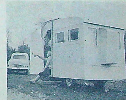
... och efter några minuter är hela husvagnen uppfälld. Bakväggen kan om så önskas fällas uppåt utåt och bilda tak över en loggia. Vagnen har fyra bäddplatser.
