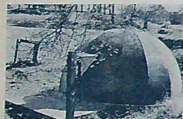
Gjutformen för betongskyddet är av plåt.
