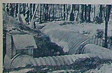
Den korrugerade plåten täcks över med jord och sten.
