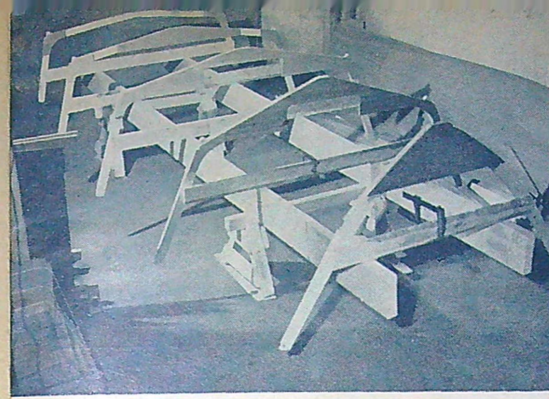
3 Huvudspanten har rests på byggjiggen. Spika inte fast dem med det samma utan fäst dem till en början provisoriskt med tvingar. Använd ett lod för att kontrollera att spanten är resta absolut vertikalt.
