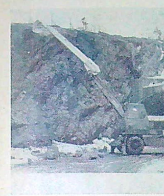
Här ses teleskopcyllindern i arbete. Observera den långa räckvidden.
