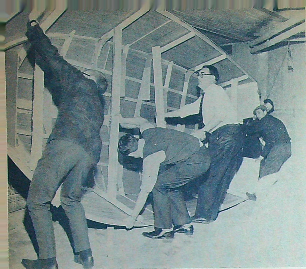
1 Det gäller att ta det försiktigt när man vänder en så pass stor och bred båt som Alnö. Skrovet till TfA:s byggsatsbåt mäter 5,60x2,18 m och i det här fallet var det inte många centimeter kvar mellan båt och tak vid vändningen. Ett båtskrov är också ganska ömtåligt i detta byggstadium.
