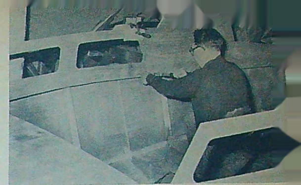
5 Kabinens framgavlar måste passas in noga. Man får här ta hänsyn till både däckets välvning (däcksbukten) och framgavlarnas vinkel gentemot varandra samt däcket.
