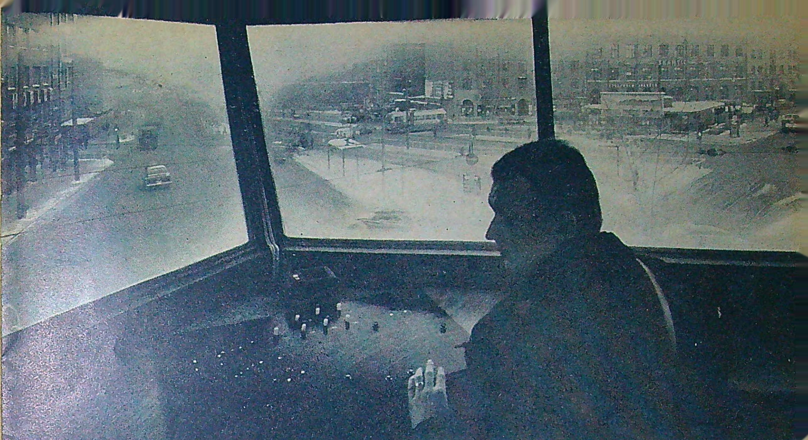
Från sitt höga torn har konstapel Torsten Lantto en god överblick över Hornsplans trafikkarusell. På manövertavlan kan han sköta alla signalgrupperna i de olika gatukorsningarna och bestämma vilka fordonsströmmar som skall släppas fram i rätt ögonblick. Med snabbtelefon står han i kontakt med brovakten.
