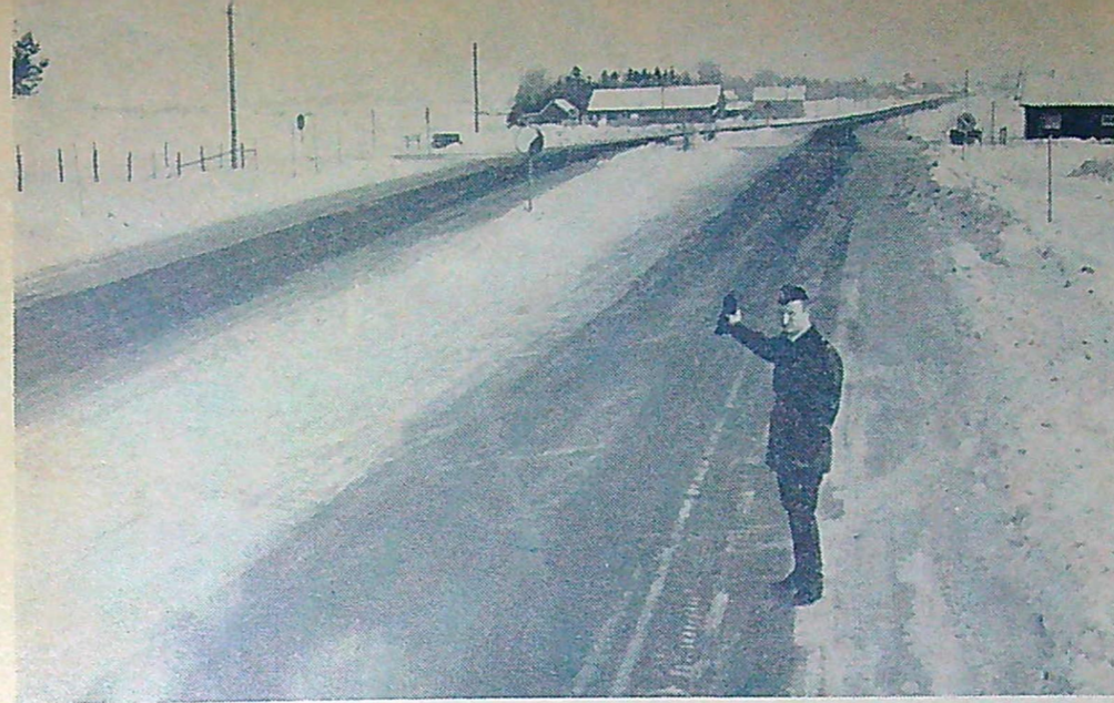
Polisassistent Leif Carlsson, Vara, vid den korsning som före justering var en av E3:ans farligaste, nämligen Asen. Bilden tagen på E3. Korsande väg har nummer 186, huvudled mellan Vänersborg—Falköping.
