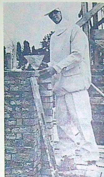
En dansk murare testar här den nya arbetsdräkten som skapats av Danska Byggnadsforskningslaboratoriet och skall möjliggöra utomhusarbete året om. 500 byggnadsarbetare landet runt håller nu på att testa arbetsdräkten.
