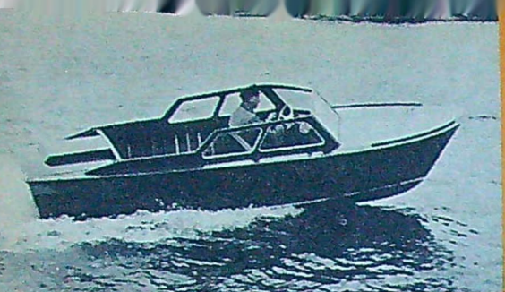
Aqua-Falken är klinkbygd med bordläggning av mahogny och mäter 5,60x2,10 m och är utrustad med Volvo Penta Aquamatic på 80 hk. Gör 28 knop. Pris med elutrustning 15 850 kr. AB Gösta Berg.
