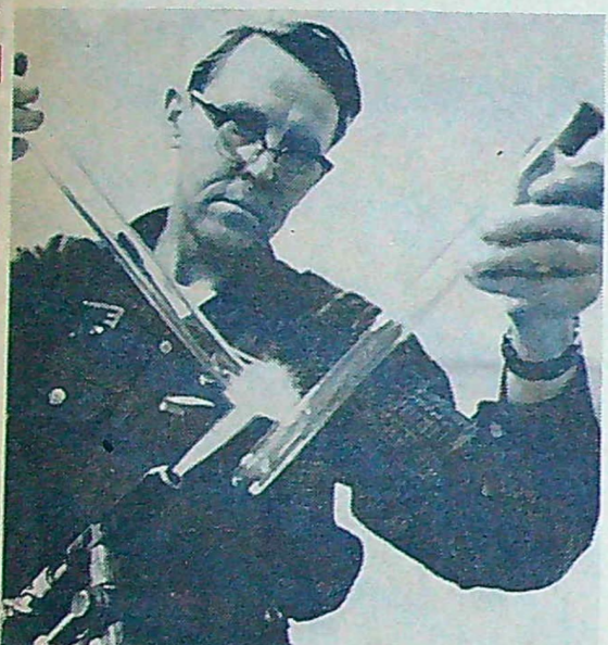
Efter bockningen, på bilden härövan, går rören till karimatan — en speciell ugn — där de värms till 520°C för att få bort spänningar i glaset.
