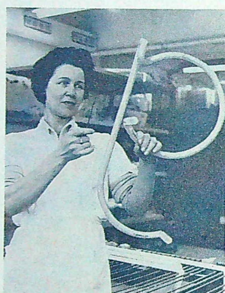
Tidigare anbringades lyspulvrets bindemedel, fosforsyra, med hjälp av med denna syra belagda glasspår, som skakades omkring i neonglasröret.
