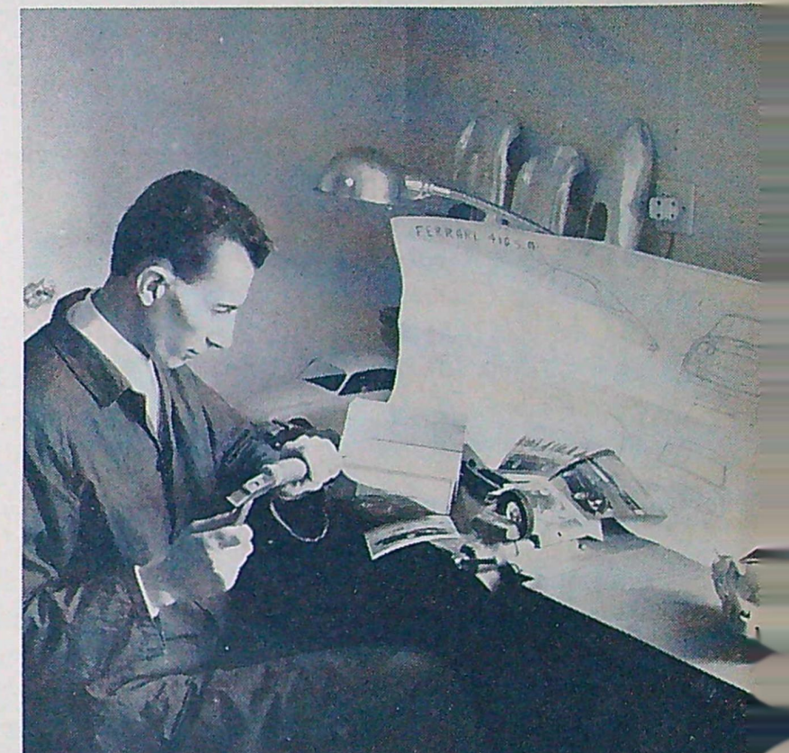
Michel Conti bygger karosserierna till sina modeller i aluminium, som emellertid hamras fram över en trämall. Finsnickeri tillhör därför alltid de första arbetsmomenten i varje nytt projekt. Karosseriet formas sedan i delar, som sedan målas.
