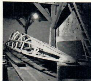
Så bygger man kroppen. Observera att konstruktionen ska vara särdeles stadig kring masten.
