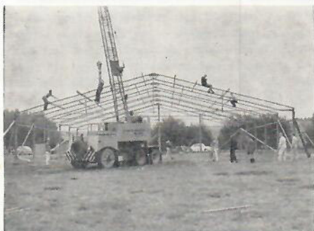
Det krävdes mycken möda, när den nya hangaren skulle uppföras. Här har man hjälp av en kranbil.
