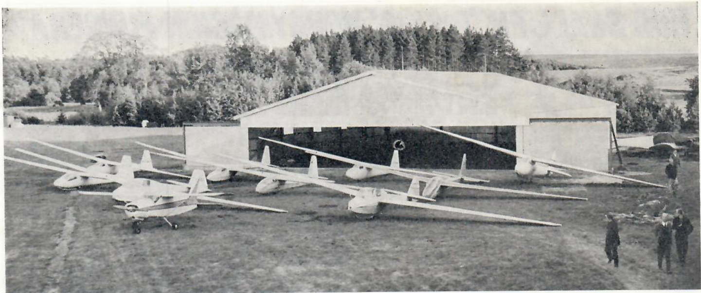
Den nya hangaren, där klubbens hela flygplansflotta får plats, utan att man behöver montera ner den. När man hade de gamla "hangarerna" var man tvungen att montera ner varje plan för att få det under tak.
