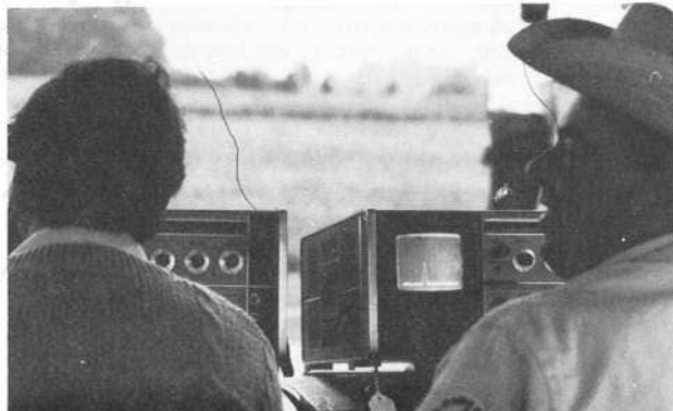
En tagg på oscilloskopskärmen visade frekvensen så fort någon sändare slogs på eller dök upp på bandet.
