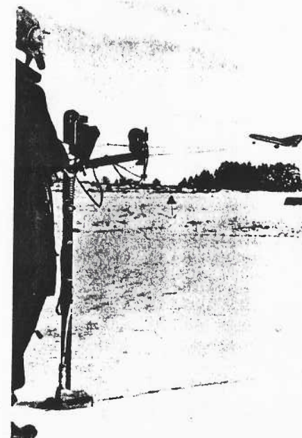
Efter att SAAB tagit hand om modellprojektet och styrsystemet ändrats till att skötas av "piloten" via en centrumpåle, blev utvärderingen bättre och lättare. Lagg märke till smalfilmskameran monterad på armen. Man filmade med hög bildfrekvens för att få slow-motioneffekt. Foto SAAB.
