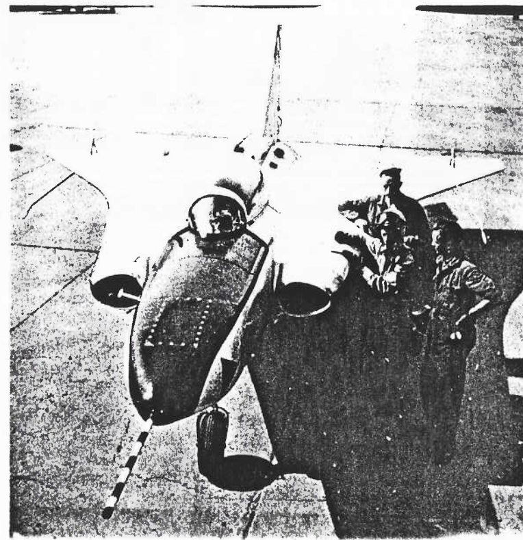
SAAB 210B där man förlängt nosen och flyttat luftintagen något bakåt. Figuren ligger här mycket nära slutprodukten – J35. Till höger Olle Klinker klar för en provflygning sekunderad av sina båda vapendragare – Kalle Norr och Torsten Nilsson. Foto SAAB.
