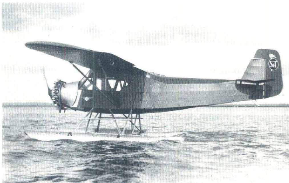
"Viking I" under motorkörning på Malmen före första flygning. Den enkla frontplåten byttes sedan till en något rundad. Tv: I luften med flottörerna på.
