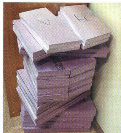
De utskurna vingarna tillsammans med restmaterialet. Restmaterialet kommer till användning längre fram på bygget
