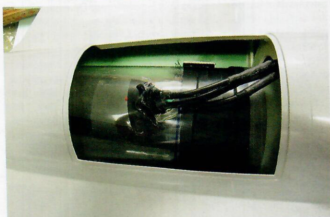
Fläktens koppling till utblåset.
